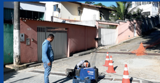
Drenagem na Rua Áureo Poli Monjardim - Fradinhos (Concluída)
