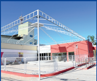
Reforma do Centro de Referência da Juventude - Monte Belo (Em execução)
