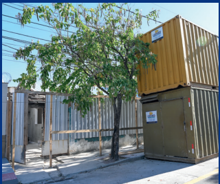
Reforma e implantação da Casa de Acolhimento - De Lourdes (Em execução)
