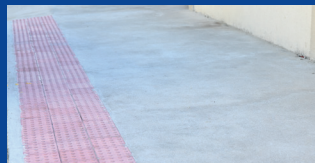
Construção de calçadas públicas - Monte Belo (Concluída)
