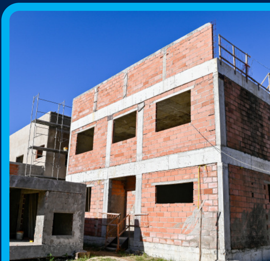
Obra da US Santo Antônio: mais da metade concluída
