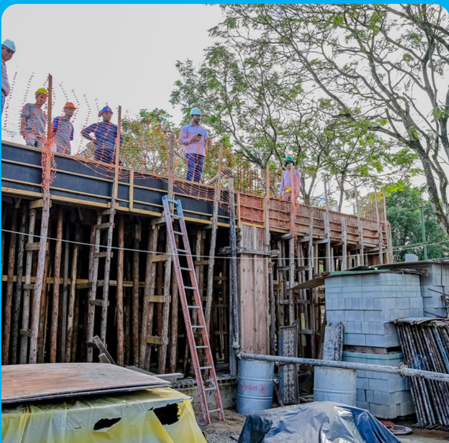
Concretagem da laje de duplicação da US Jardim Camburi
