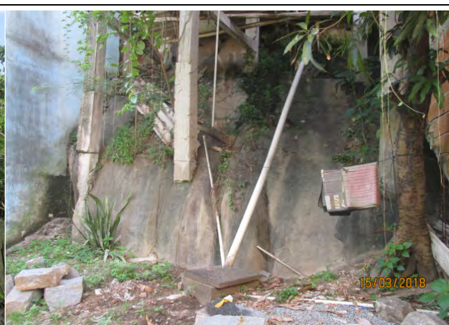
Foto 08: Maciço Residual de Granito com fundação de ocupação irregular no Bairro Nova Palestina.
