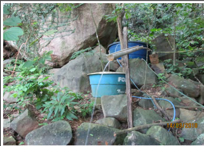
Foto 01: Sistema de Captação – Nascente da Capixaba
